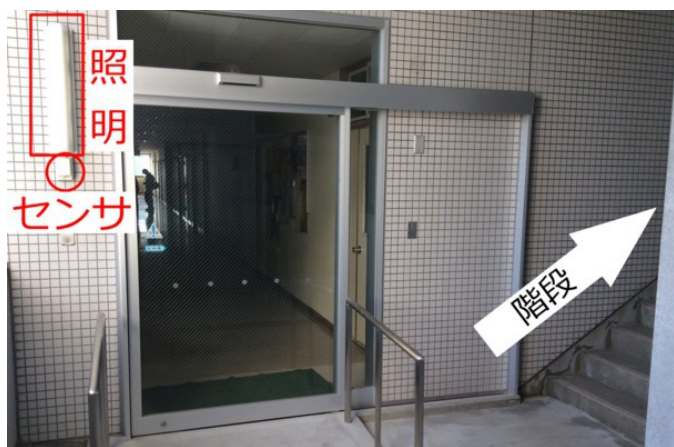
図1: 既存照明と非常階段の位置関係
